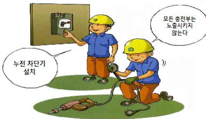
〈그림 67〉 누전차단기 설치 및 충전부 마감처리 예
