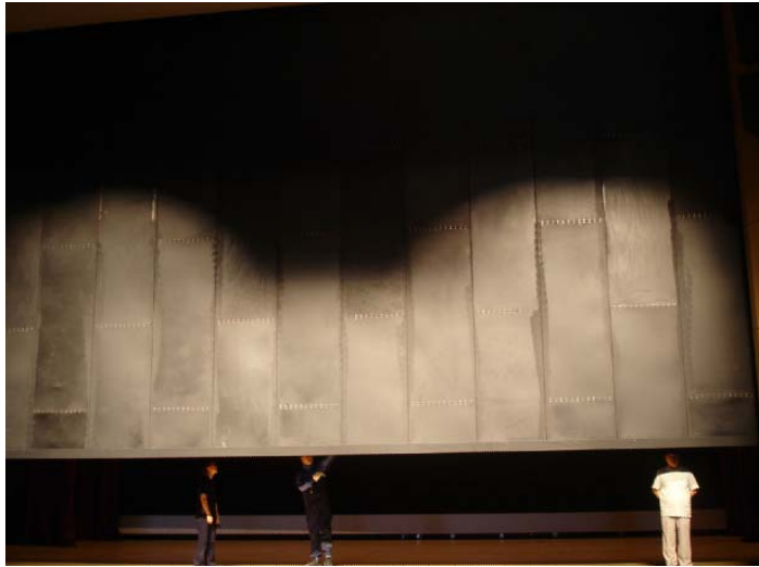
〈그림 113〉 방화막 설치 예
